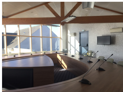
Une salle de conseil mal isolée, une répartition du personnel dans l'équipement perfectible
