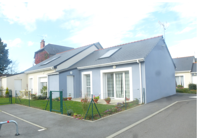
Espaces extérieurs privés d'habitats inclusif à Nozay (44)
