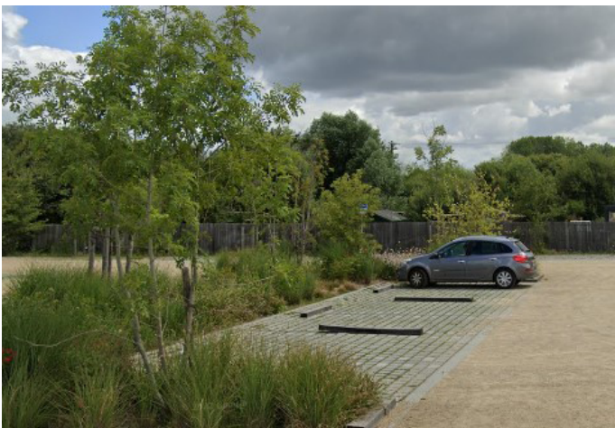
Sols poreux et désimperméabilisation des espace de stationnement - Port de Rozé - MAP [PAYSAGISTES]
