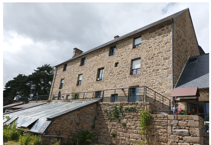
Rénovation de bâti en ancien en appartement avec espaces communs à Luvigné (35)
