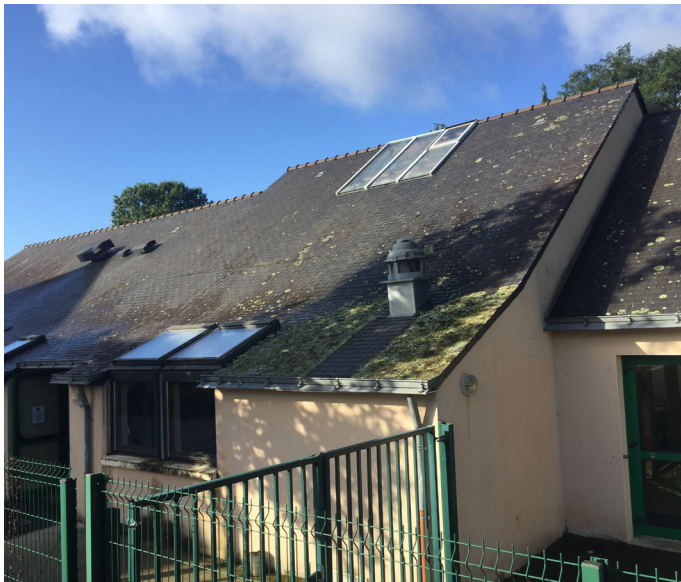
Réfectoire cantine scolaire
