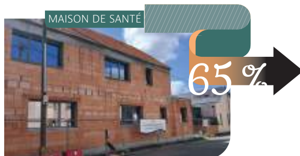
Bâtiment hors d'eau - hors d'air.
